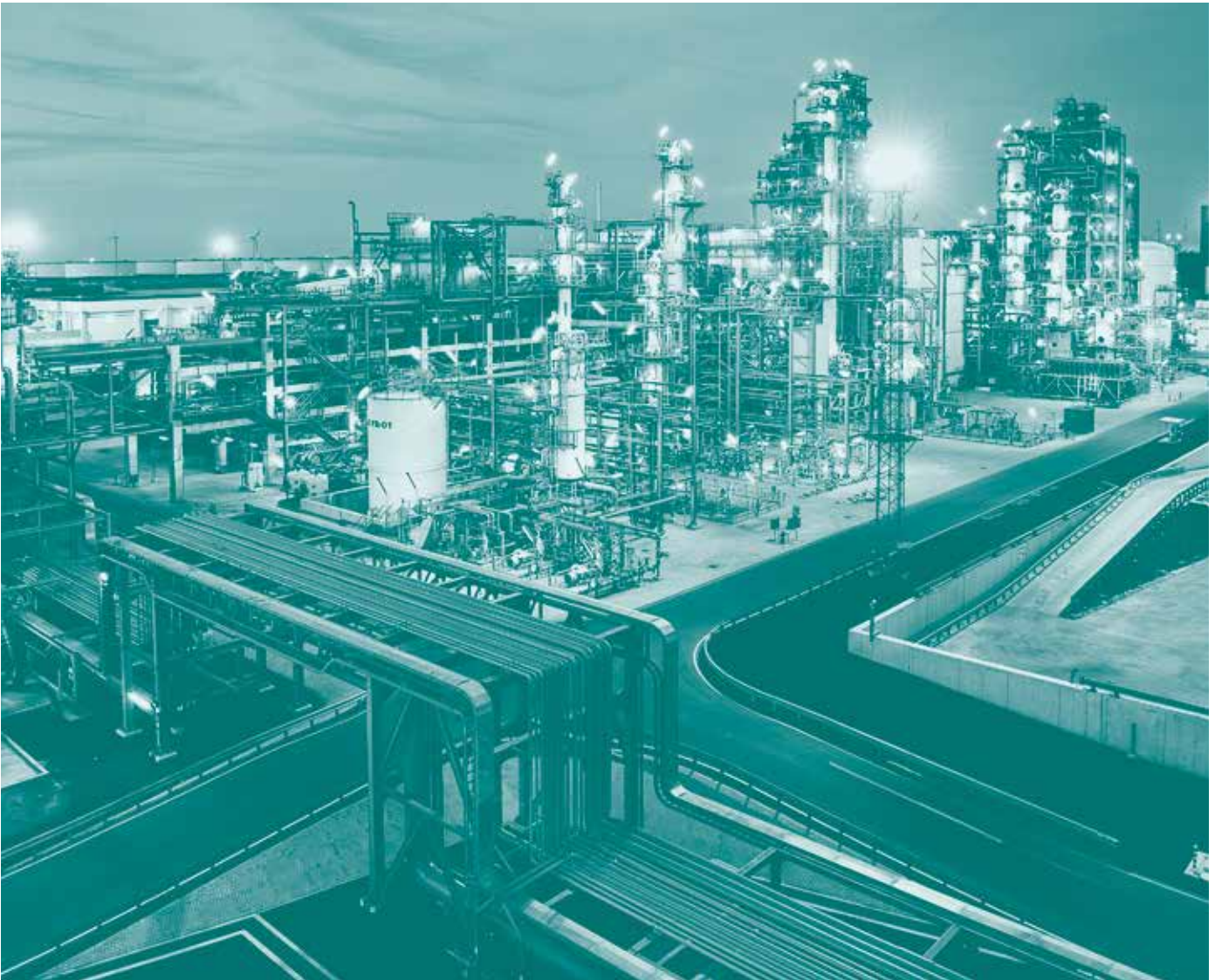
Neste valmistaa uusiutuvaa dieseliä Rotterdamissa, Singaporessa ja Porvoossa
